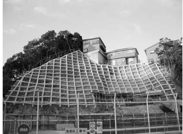
写真8 SH型貫入試験による調査を実施した斜面での工事例(神奈川県)
