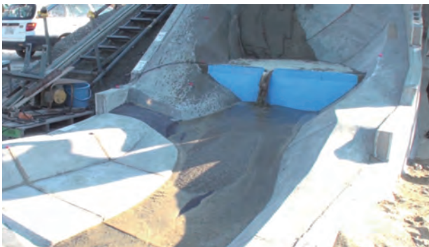
写真-5 計画原案実験状況（水通しからの流出状況）
