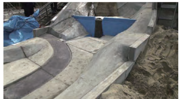
写真-7 最終案実験状況（水通しからの流出状況）
