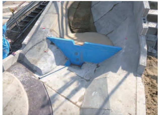
写真-6 最終案実験状況（水抜穴閉塞状況）
