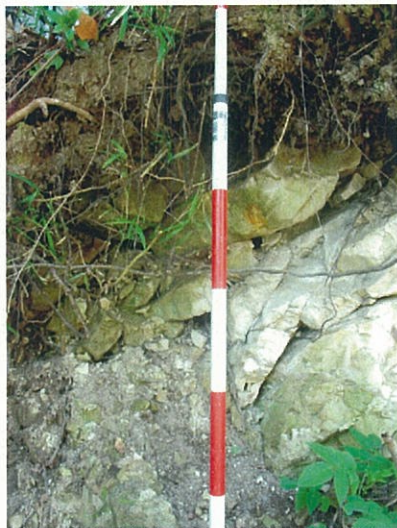
図 17 露頭状況 (P-13 付近)
